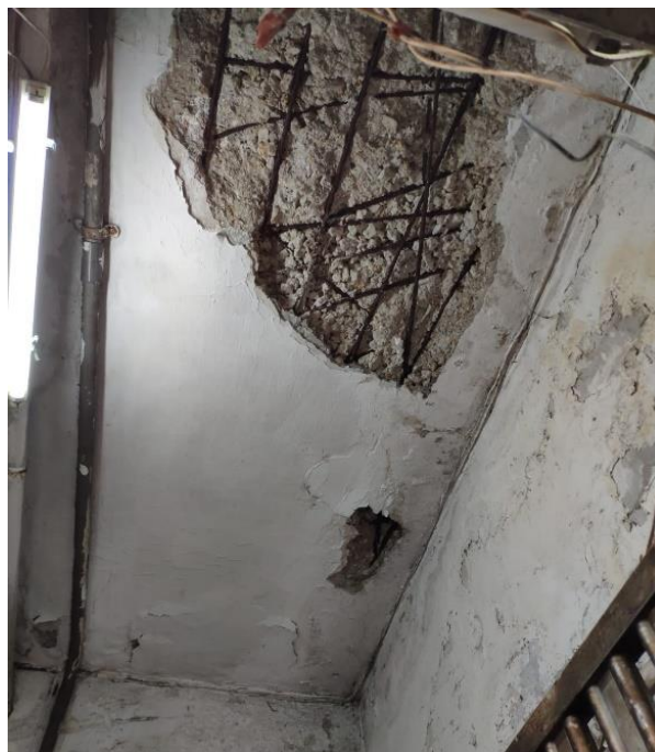
有「三無大廈」走廊石屎剝落，鋼筋外露。(油尖旺區議員李思敏供圖)
