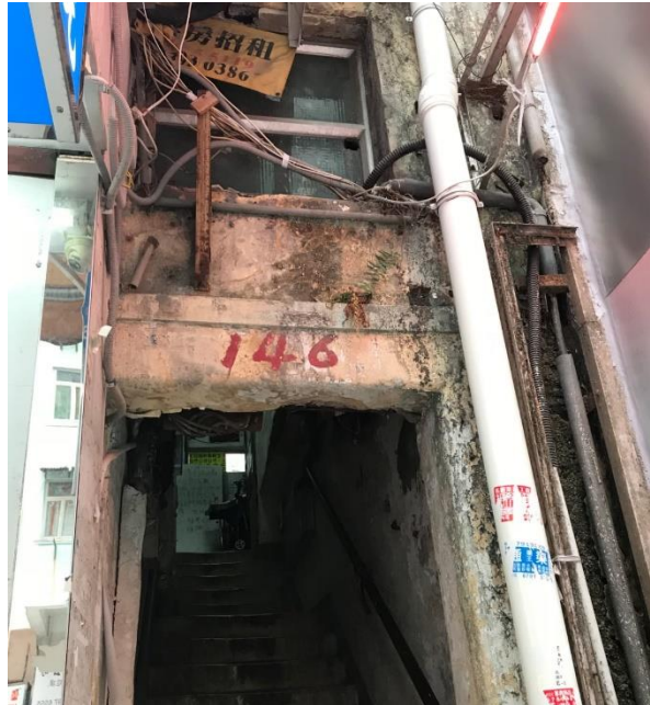
大南區有「三無大廈」門口殘破，電線外露。 (油尖旺區議員李思敏供圖)
